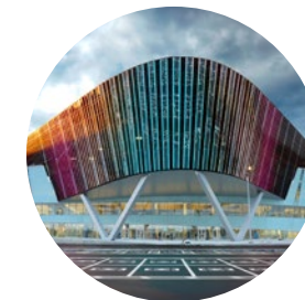
Строительство конгресс-центра МВЦ «Екатеринбург-Экспо»
