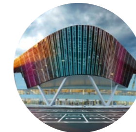
Строительство конгресс-центра МВЦ «Екатеринбург-Экспо»
